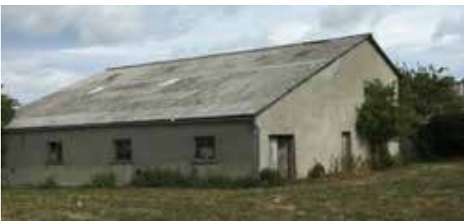
Reprise de la toiture et des sols à la grange Lavigne
